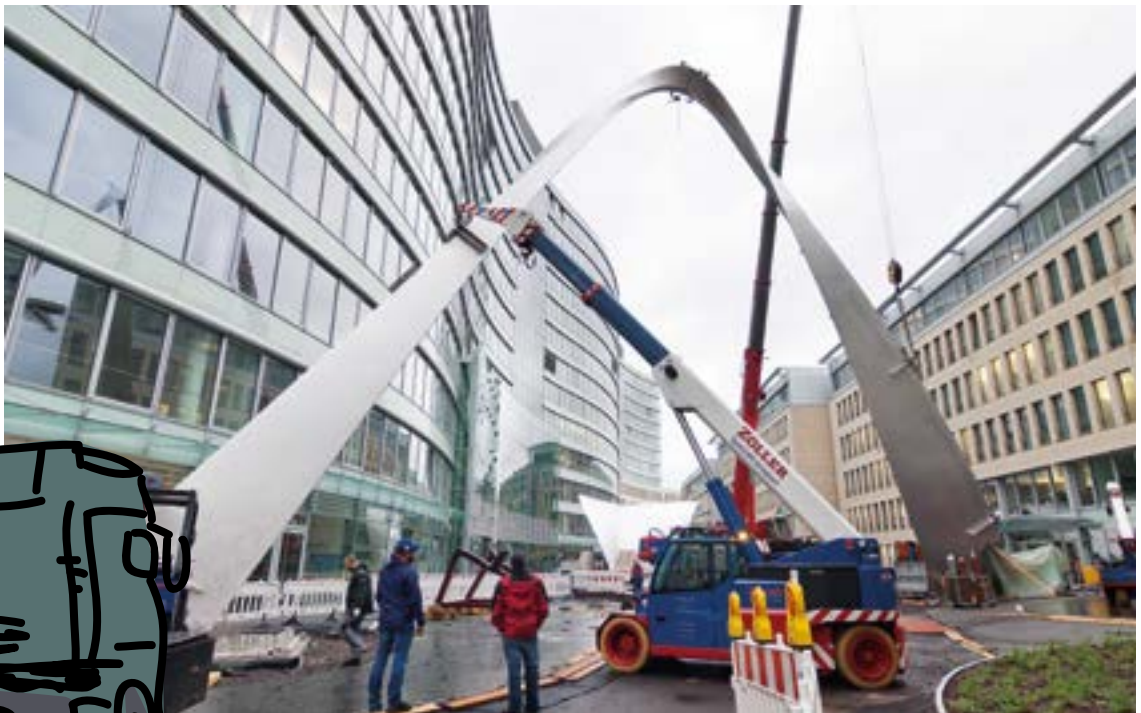
Das war wahre Millimeterarbeit: Sattelschlepper bugsierten die riesigen Bögen für eine Aluminiumskulptur zwischen die Gebäude des Frankfurter Bürokomplexes „Die Welle“, wo sie schließlich verschweißt, aufgerichtet und montiert wurden | Bild: M. Pyper
